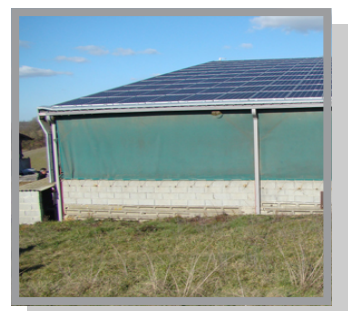
Bâtiment agricole avec toiture photovoltaïque
